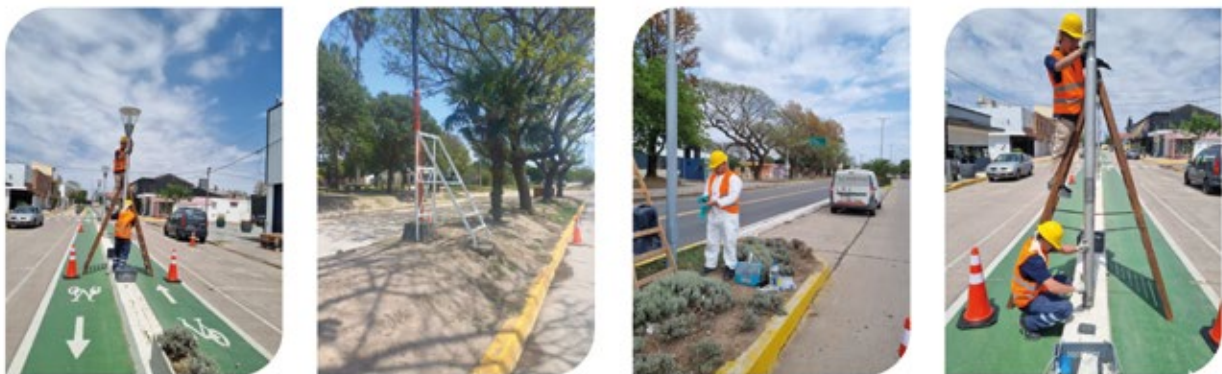
Figura 3. Proceso de preparado y aplicación de la pintura en el proyecto piloto en Laguna Larga
