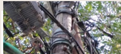
Trabajos en la vía pública del AMBA
