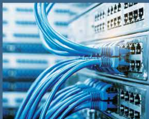
Redes Multimedia y Telecomunicaciones
