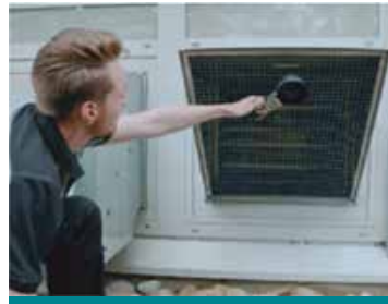
Figura 1. b) Para medir correctamente, la salida de aire solo se cubre con el brazo y el instrumento de medición de modo que el aire pueda fluir sin impedimentos.
