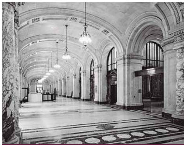
Figura 1. La iluminación artificial complementa cuidadosamente la luz del día en este vestíbulo histórico.
