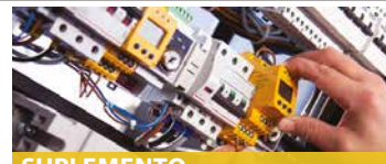
SUPLEMENTO INSTALADORES — Pág. 49
