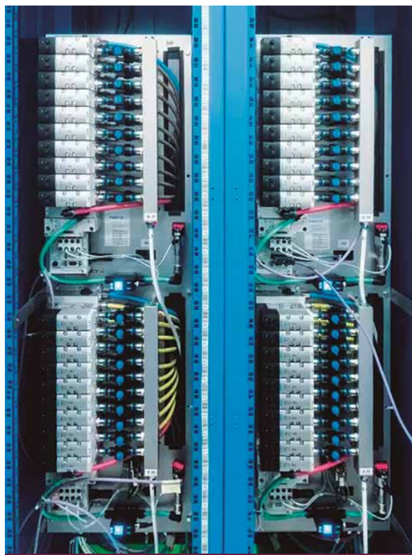
Figura 2. Funcionamiento reversible: mediante vacío, el terminal de válvulas VTSA conduce las corrientes de aire desde unas cien estaciones de medición hasta los dispositivos de análisis.
