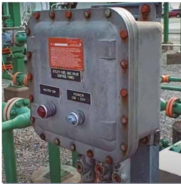
Figura 10. Caja a prueba de explosión NEC
