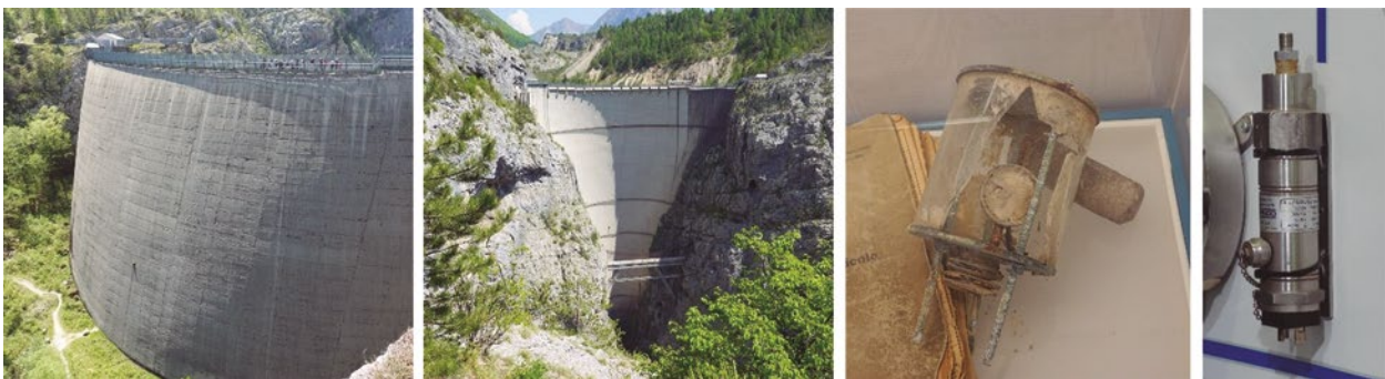
Figura 1. Dique del Vajont. De izquierda a derecha. 1 y 2) Vista actual de la pared del dique, la primera es aguas arriba y la segunda, aguas abajo. Se puede apreciar la enorme diferencia entre los niveles del suelo, lo que da una idea del volumen del deslizamiento. 3) Uno de los cuestionados piezómetros, hoy expuesto en el museo conmemorativo de Longarone. 4) A veces los piezómetros ayudan a salvar una represa. Aquí una imagen de un transmisor de presión empleado durante las obras de impermeabilización del núcleo arcilloso del dique El Chocón, tal como se expone en la vitrina de auscultaciones en el Museo Villa El Chocón. Según conocimiento del autor, este es el único instrumento con procesos de fabricación argentinos mostrado en un museo público del país.
