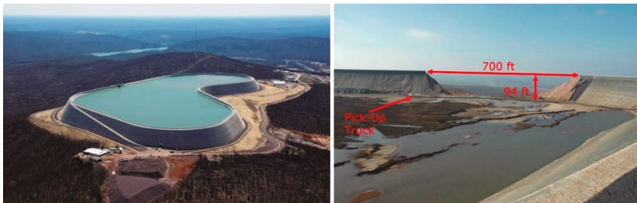
Figura 3. Central hidroeléctrica de rebombeo Taum Sauk. A la izquierda, vista general del reservorio superior luego de su reconstrucción. El punto minúsculo que se ve en la pared izquierda es la caseta donde originalmente estaban instalados los interruptores de nivel. A la derecha, la magnitud del desmoronamiento producido por el desborde.
