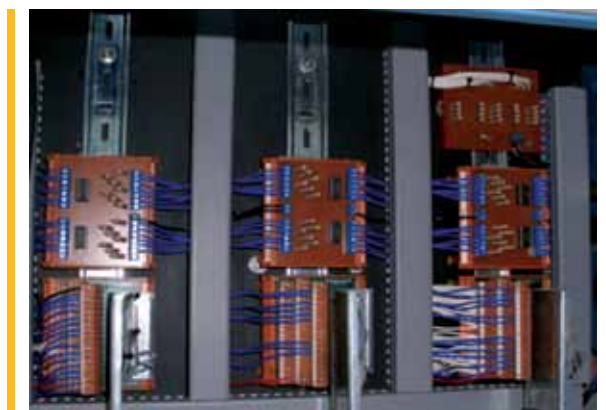
Figura 7. Placas de adaptación de interfaces instaladas
